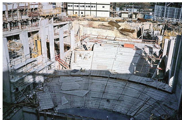
Grand Écran en construction.
